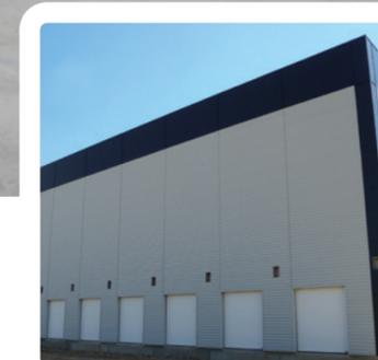
“ **Des murs coupe-feu d'une hauteur de 17,35 mètres** avec une trame de charpente optimisée permettant la libre circulation d'un convoyeur textile de 5 kms ! ”
