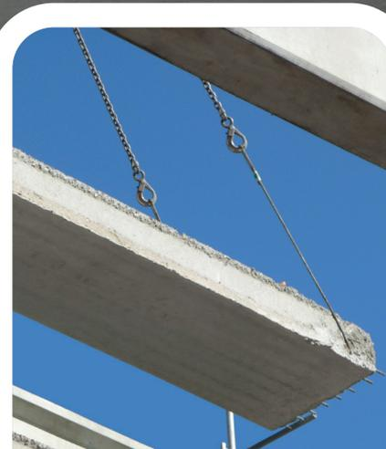
Un système de levage composé de 2 élingues intégrées à la fabrication de la dalle pour une mise en oeuvre simple et parfaitement sécurisée des planchers.
